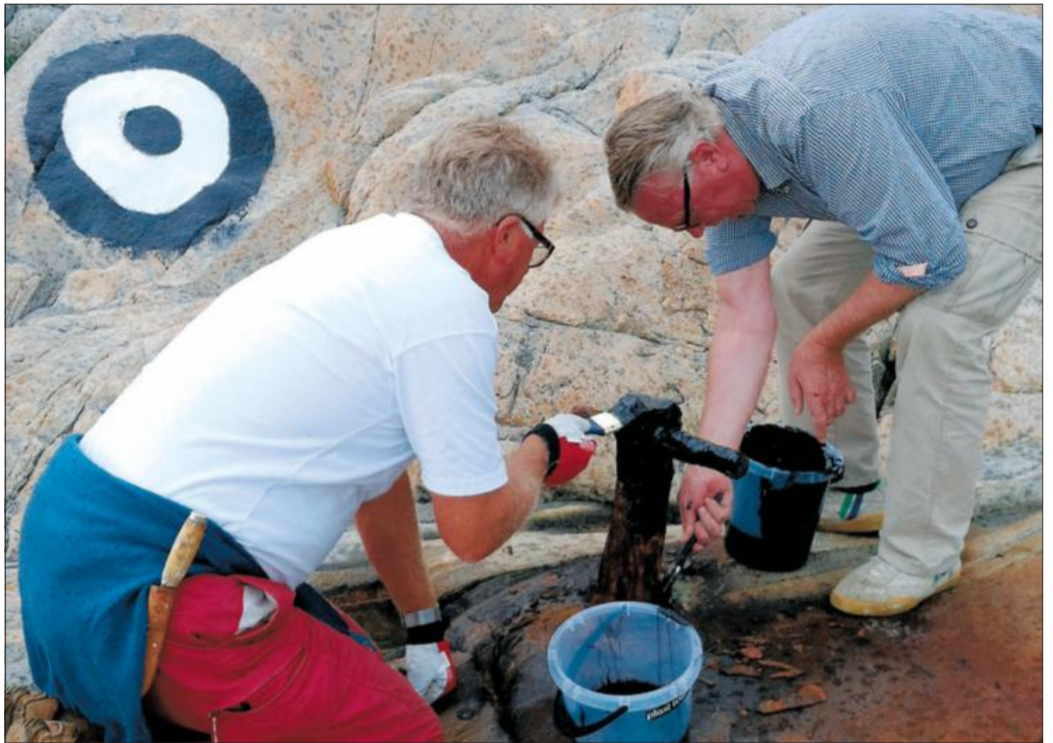
VIKTIG: Fortøyningsringene og boltepålene ble malt med maling som beskytter mot rust. Det er Kystverket som har gitt malingen. Totto Mykland og Konrad Augemo var to av flere som var ute i skjærgården.
